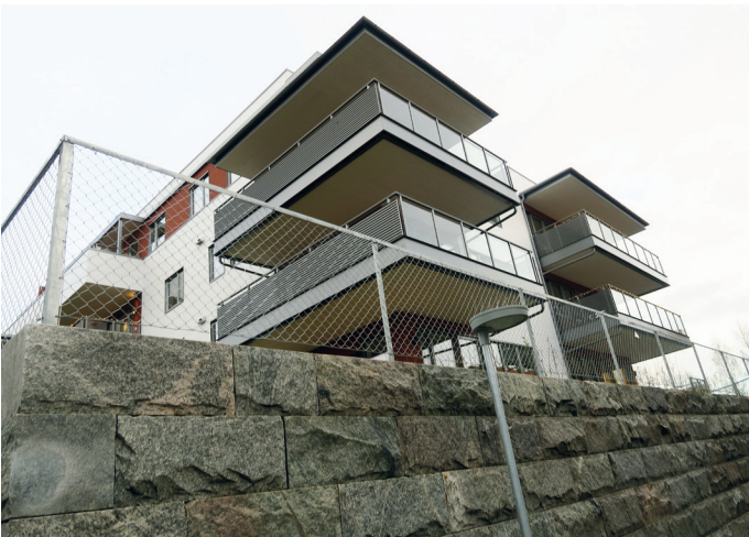
Utkragede balkonger preger deler av prosjektet.
