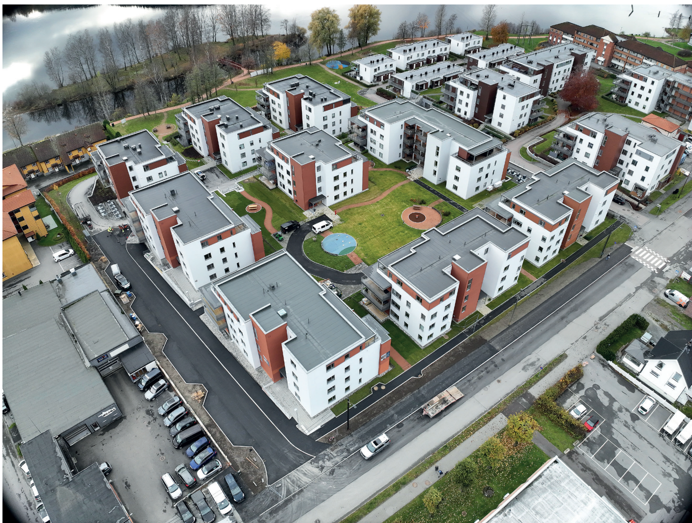
Foto: Brevik Maskinentreprenør
